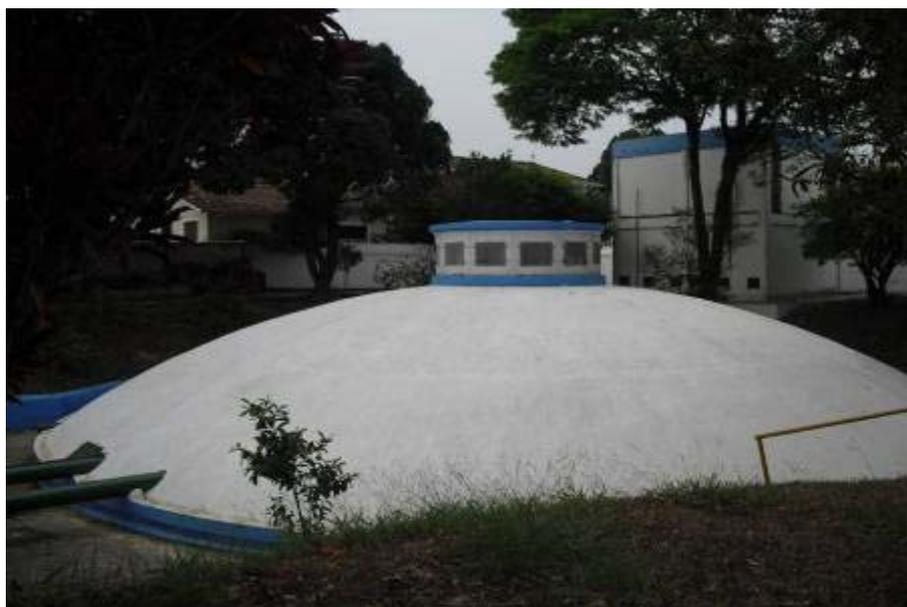
1449 **Foto 13 - Reservatório enterrado localizado na ETA – capacidade de 1.000 m<sup>3</sup> (Fonte: PlanSan123)**
